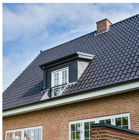
Pultkvist beklædt med mørk zink bevarer tagets rolige fladevirkning og skaber harmoni til facaden.
