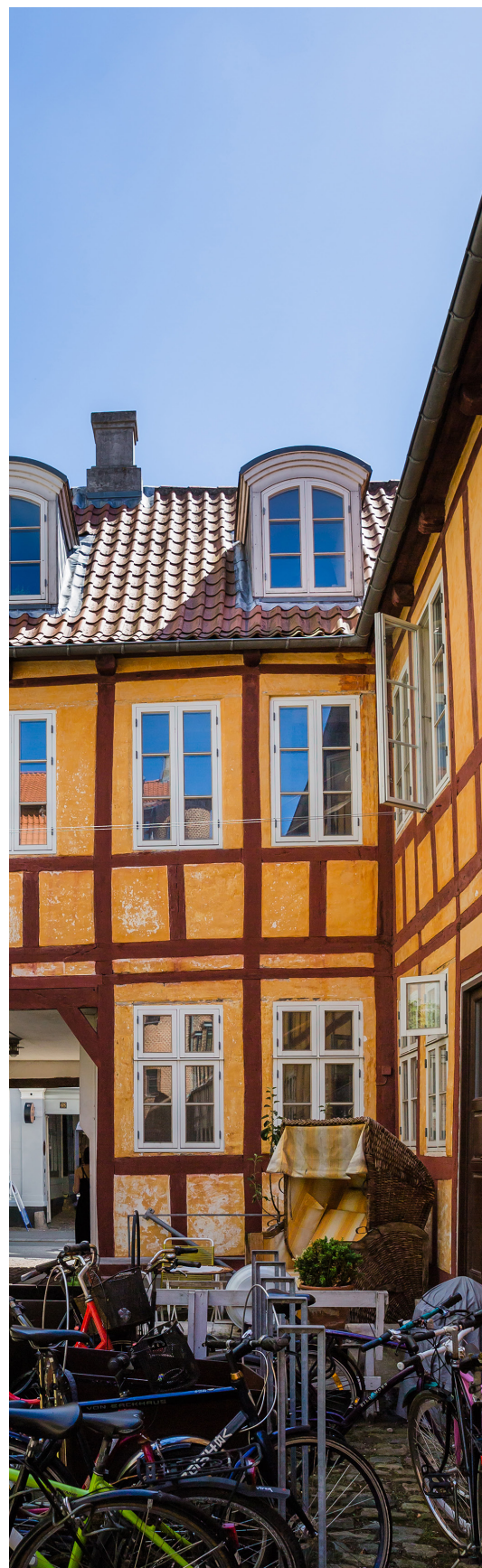
Smalle kvistflunke på bevaringsværdig ejendom harmonerer med hovedfacadens vinduer.
