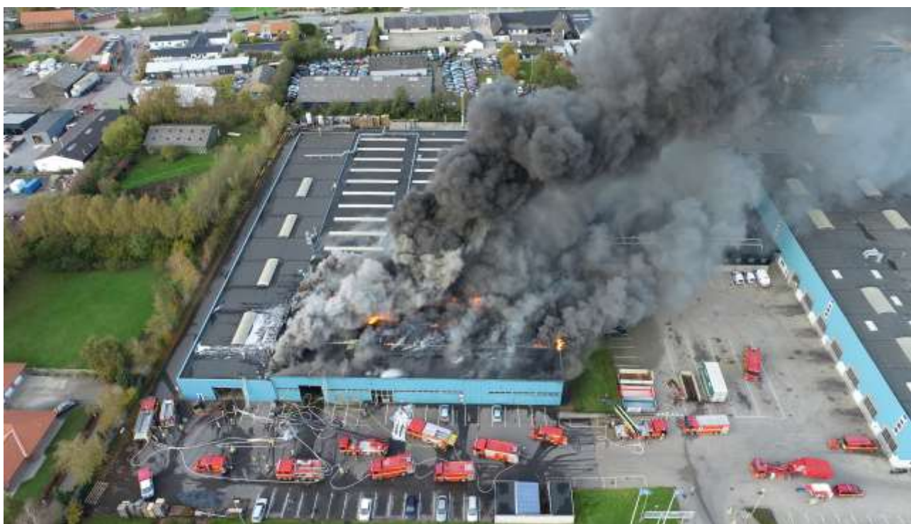
Fig. 1 Brand hos Højbjerg Maskinfabrik i Galten, 2021
