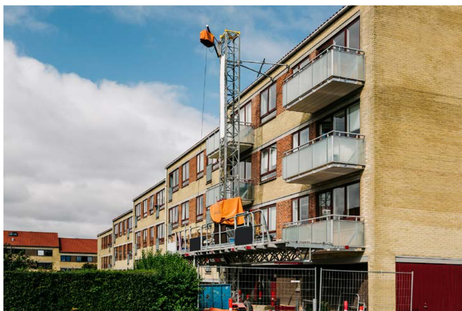
Foto: Igangværende altanbyggeri.
