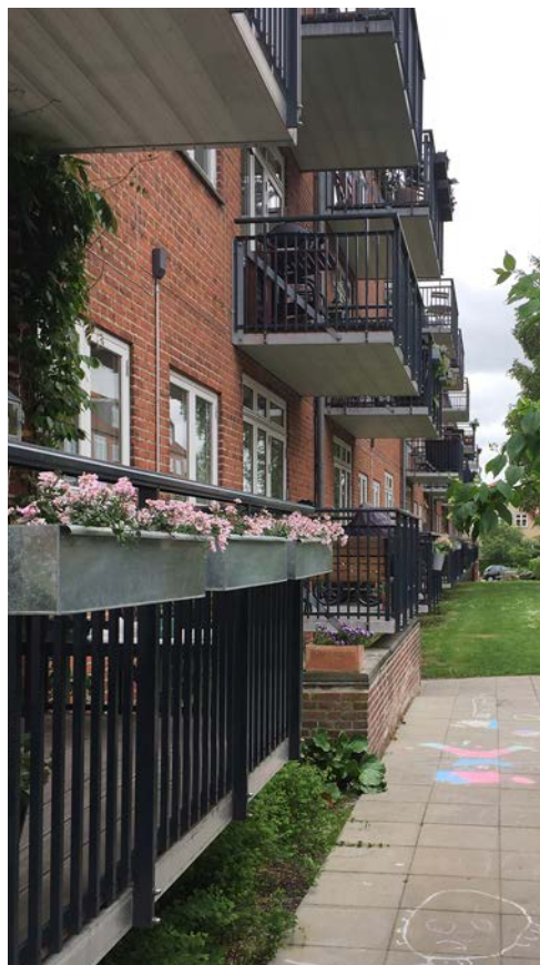
Foto: Lavtsiddende stuealtaner i samme omfang som øvrige altaner.
