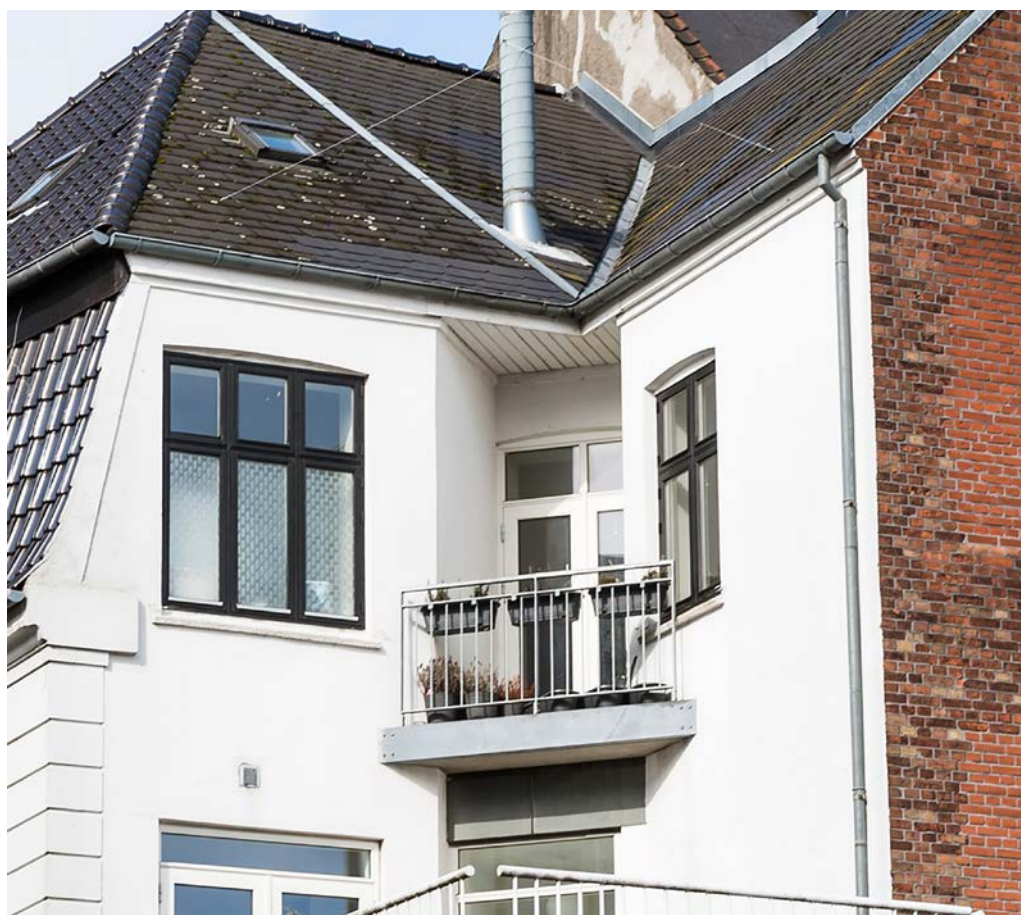
Foto: Altan i indhak i indeliggende hjørne. Særlige forhold omkring dagslys og anvendelse i underliggende lejlighed muliggør lille altan.
