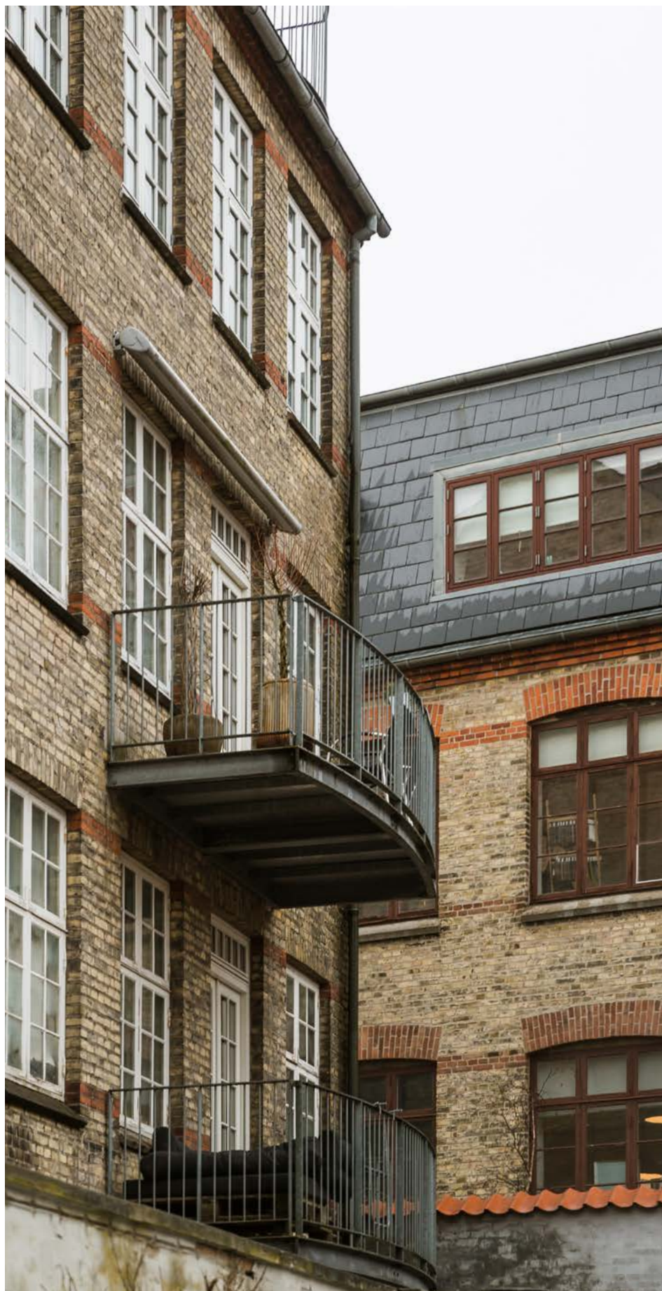
Foto: Altan uden synlig bæring og med buet front.
