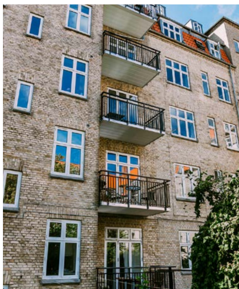
Foto: Altaner over 1 vinduesfag.
