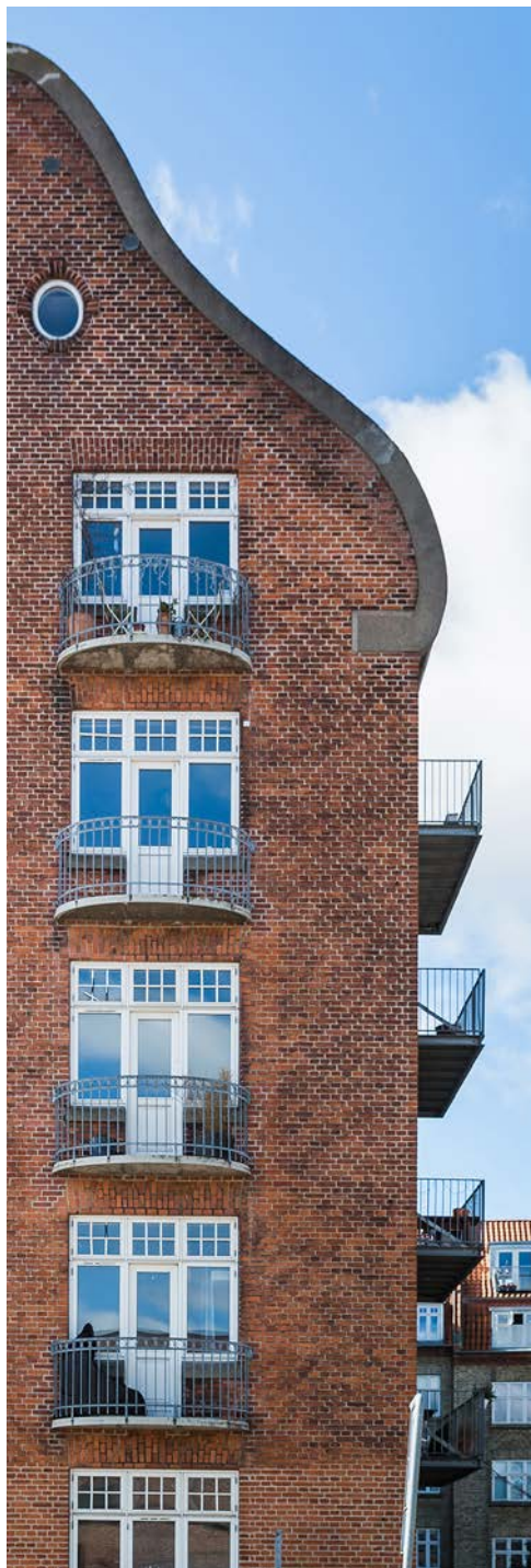
Foto: Ejendom med oprindelige altaner på gavl, nye altaner mod gård.
