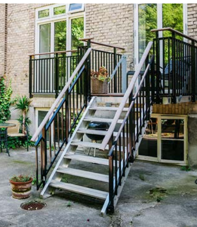
Foto: Fransk altan over kælderbolig. Udgang til gård med repos.
