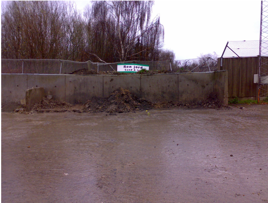
Billede nr. 1: Opbevaringspladsen på Eskelundvej er omkranset/afgrænset af betonstøttevægge på tre sider.
