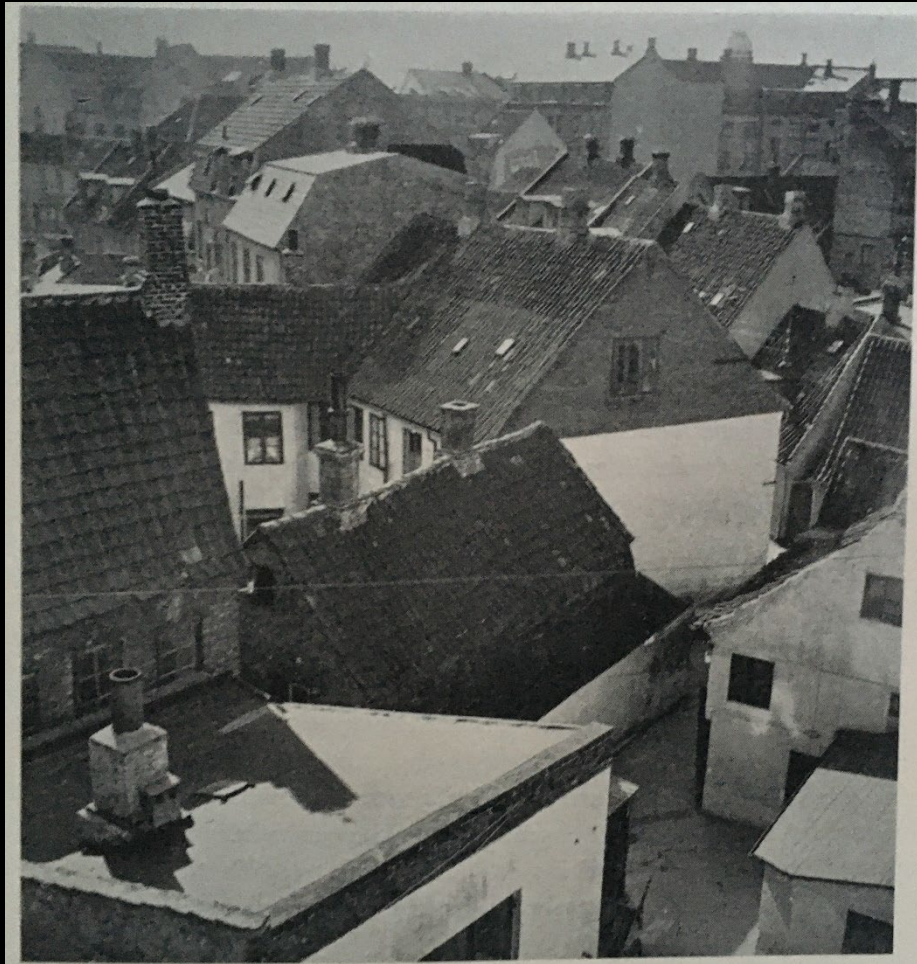
28. Indre by. Udnyttelsesgraden er ikke høj, men bebyggelsen er tæt og planløs.
